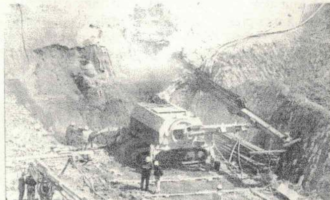
Perforació del nou túnel que desdoblirà el trànsit entre La Vall i La Costera.
